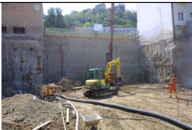
Baugrubensicherung, Sommer 2002
